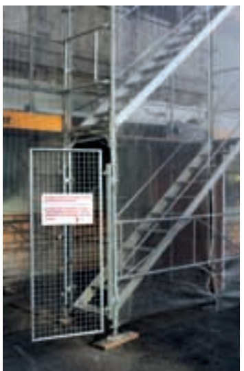
7 Accesso sicuro al ponteggio.
