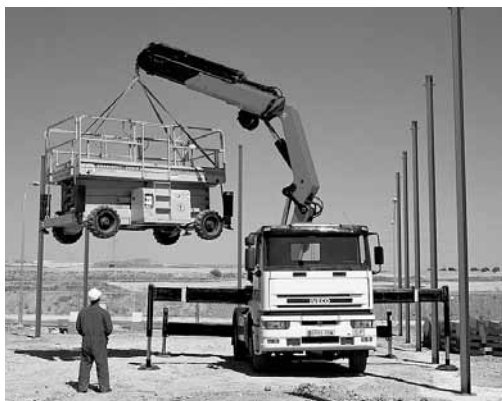
Foto 6 autogrù: gru montata su camion con momento di carico superiore a 400'000 Nm o uno sbraccio superiore a 22 m
