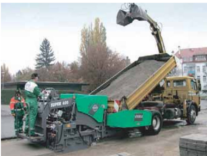
TRAIN DE POSE A 3 FINISSEUSES EN PARALLELE
