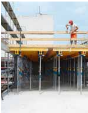
Regel 1 Absturzkanten sichern.
