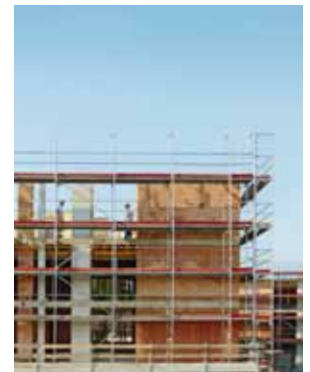
Regel 4 Fassadengerüst erstellen.
