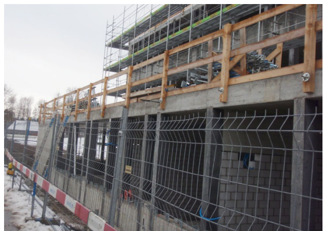
1 Korrekter dreiteiliger Seitenschutz gemäss SN EN 13374
