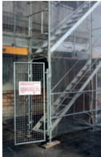
7 Sicherer Gerüstaufgang.
