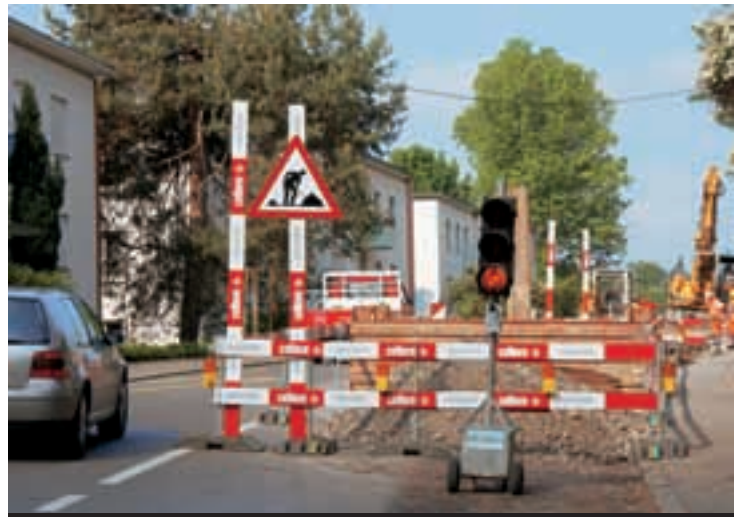
1 Aushubmaterial als Sicherheitspuffer.
