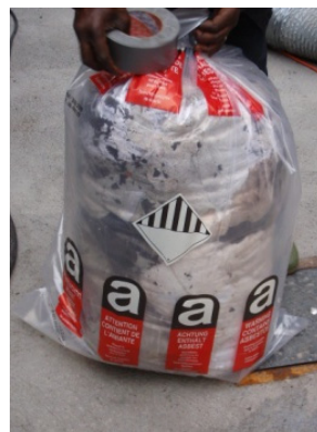
6 Kunststoffsack mit der Kennzeichnung «Asbest»
