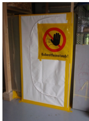
4 Dieser Sanierungsbereich ist sauber räumlich abgetrennt und gekennzeichnet.
